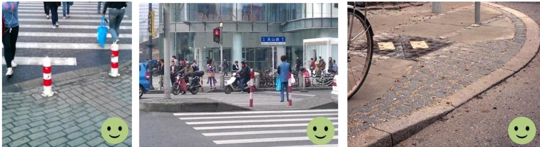
图 5.4.2 路缘石缓坡处理正例
